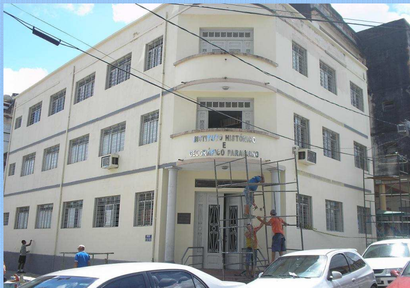
Sede do IHGP em reforma: Pintura e instalação do letreiro.
